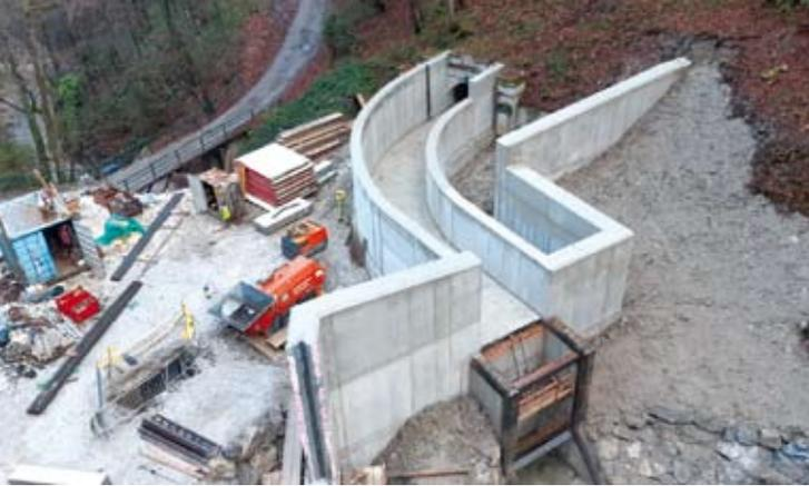
Abb.19 Einlaufbauwerk im Bau)
